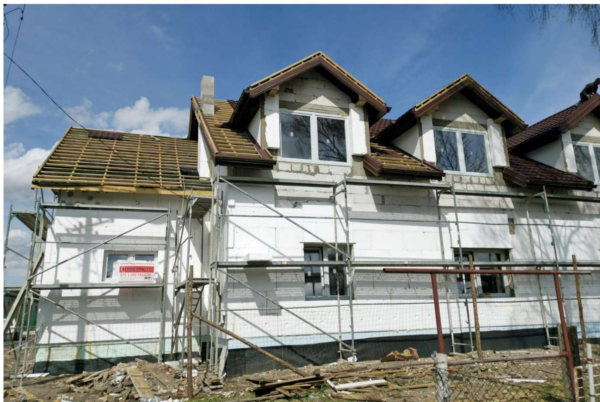
Foto: Odbudowa spalonego budynku komunalnego przy ul. Pokrzywnej w Piątku
